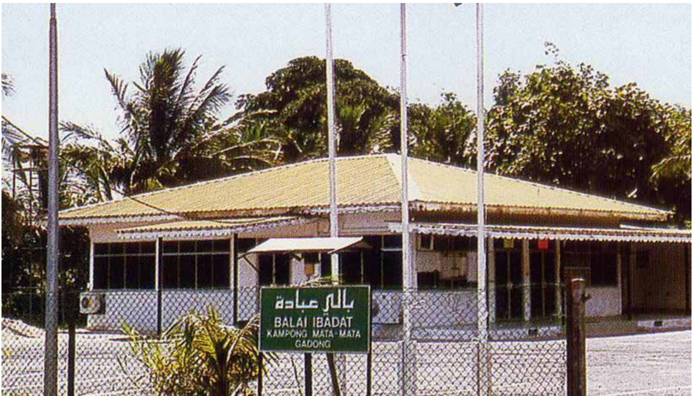
Bangunan Lama Balai Ibadat Kampung Mata-Mata, Gadong.
