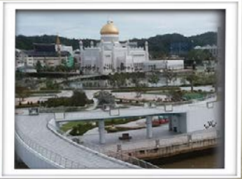
Jambatan Pejalan Kaki
